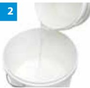
2. Смочить емкость водой, отмерить необходимое количество воды комнатной температуры и вылить в емкость. Расход воды составляет: на 1 кг сухой смеси – 0,26-0,27 л, на 5 кг – 1,3-1,35 л, на 25 кг – 6,5-6,75 л.
