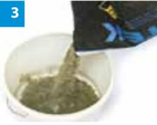
3. Разрезать мешок, отмерить необходимое количество смеси и постепенно высыпать ее в емкость с водой. Перемешать при помощи строительного миксера или дрели со специальной насадкой до получения однородной массы.
