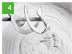
4. Перемешать при помощи строительного миксера или дрели со специальной насадкой до получения однородной массы.
