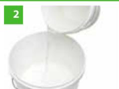
2. Смочить емкость водой, отмерить необходимое количество воды комнатной температуры и вылить в емкость. Расход воды составляет: на 1 кг сухой смеси - 0,5-0,55 л, на 5 кг - 2,5-2,75 л, на 20 кг - 10,0-11,0 л.
